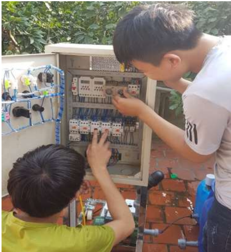
Lắp đặt các thiết bị trong tủ điện
