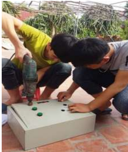
Khoét lỗ lắp nút nhấn ngoài cánh tủ
