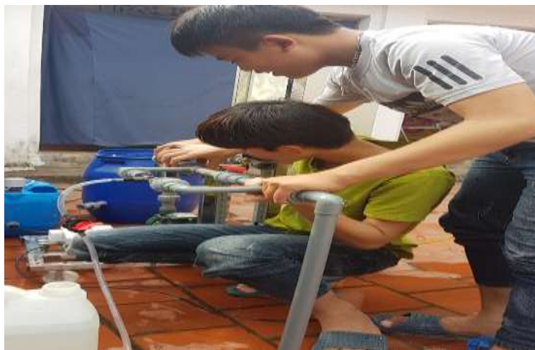
Lắp đặt đường ống
