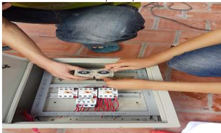
Lắp đặt tủ điện
