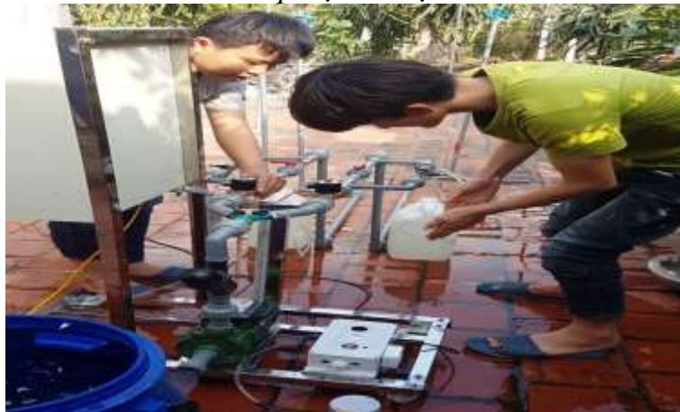
Lắp đặt chạc chữ Y và 2 van điện
