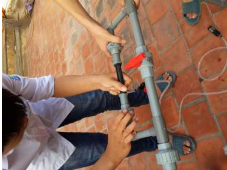
Lắp đặt bộ hút phân Venturi
