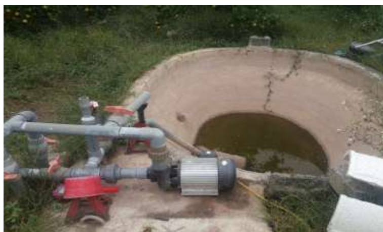
Hình 2.6: Hệ thống tưới nước bán tự động tại nhà vườn An Thái
